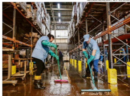
Trabalhadores removem lama de fábrica em Encantado (RS)
