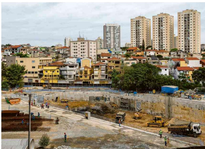
Canteiro de obras do Metrô no Jardim Têxtil, na zona leste de São Paulo. Adriano Vizoni/Folhapress
