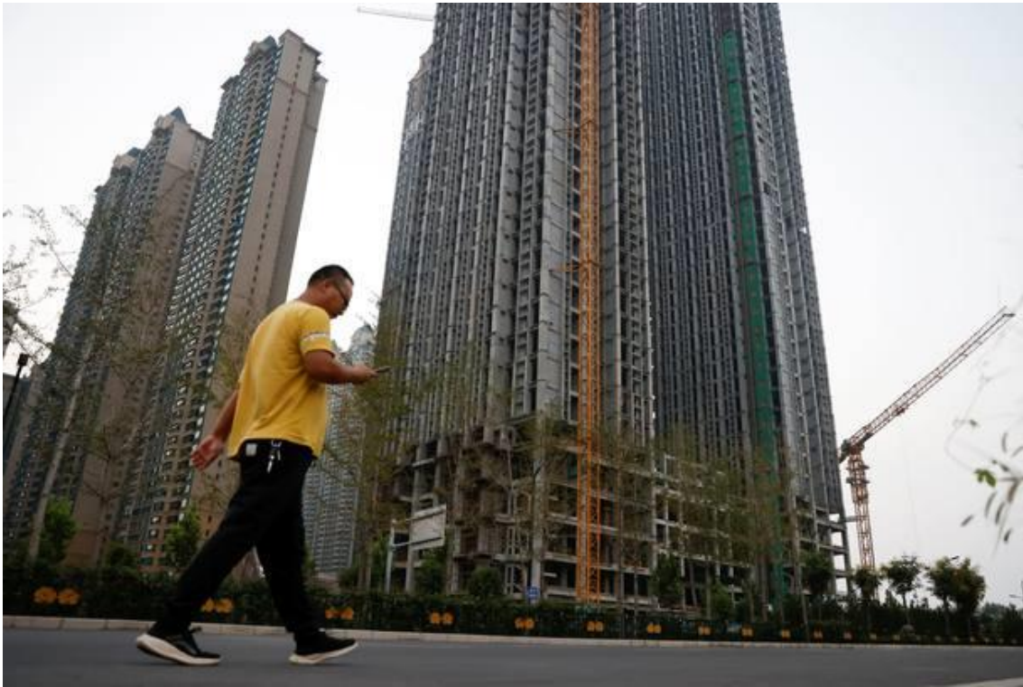
Prédios residenciais em construção na cidade de Luoyang: a Evergrande tem cerca de 800 projetos inacabados em toda a China. (Foto: Carlos Garcia Rawlins/Reuters - 15/9/2021)
