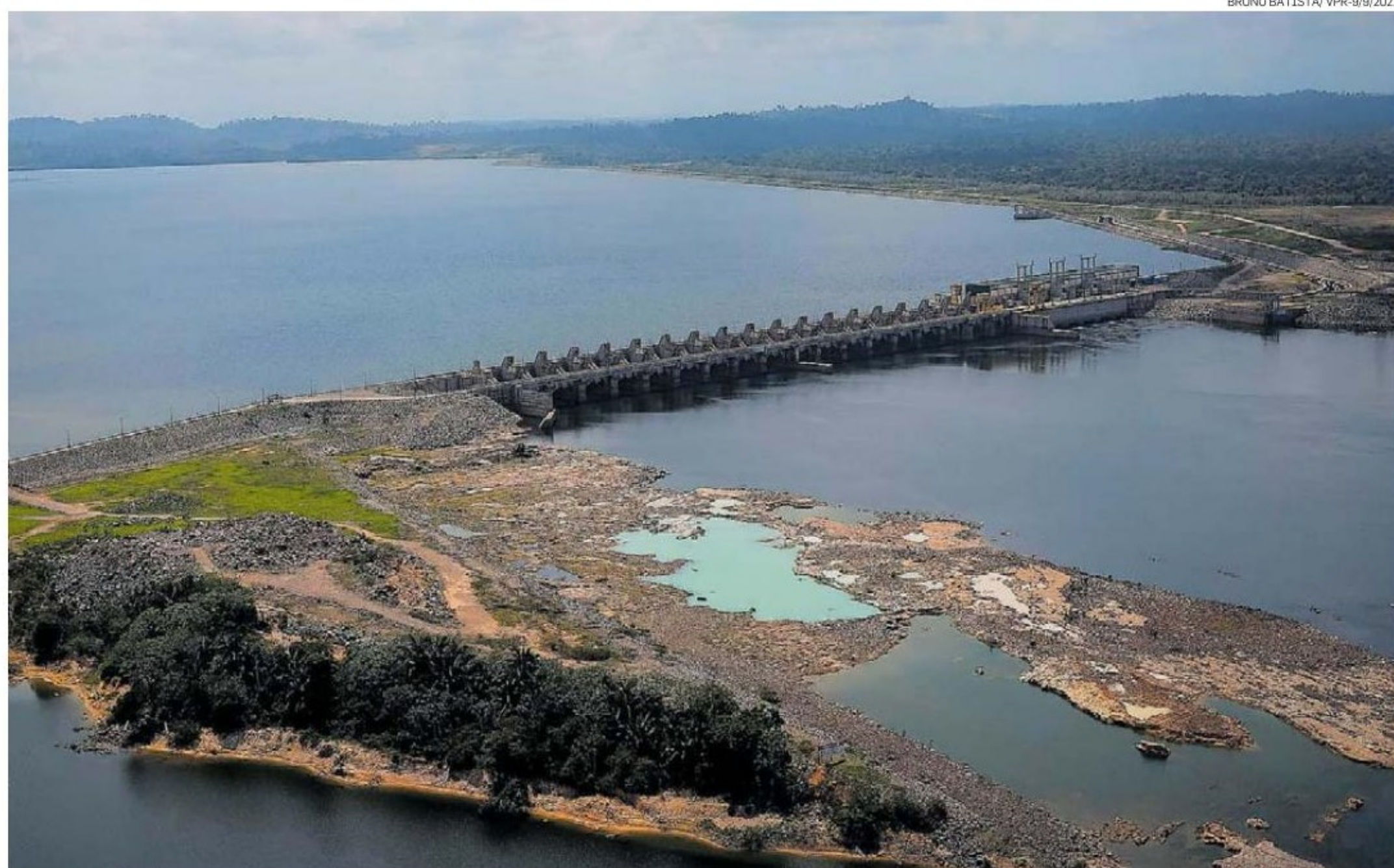
Sem utilização. As 18 turbinas de Belo Monte dependem do regime hidrológico do Rio Xingu para entrar em operação
