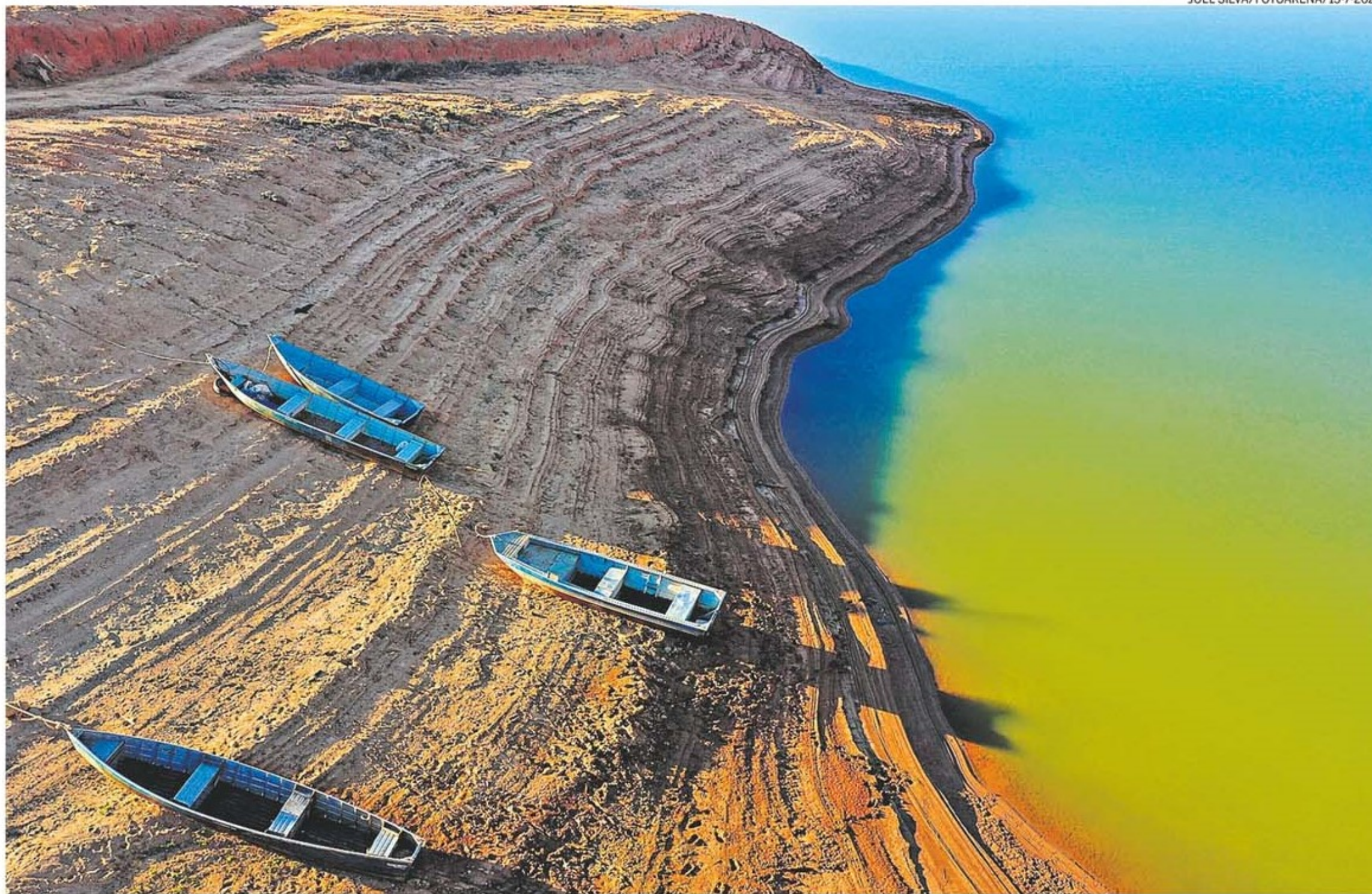
Fontes secando. Reservatório da hidrelétrica de Caconde (SP), em nível crítico. A queda no volume de água das usinas reduz a geração de energia no Brasil
